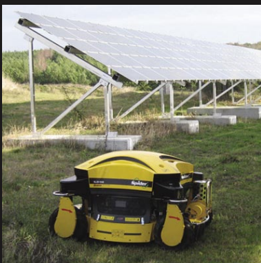
Solarpark Parcs solaires
